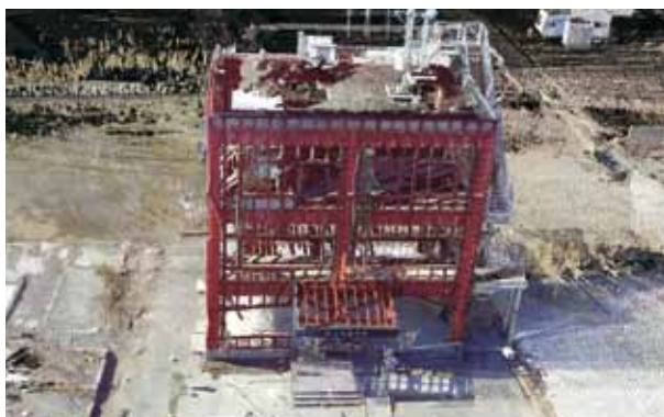
宮城県南三陸町防災対策庁舎の3次元クラウドデータを上空の視点から見た状況
