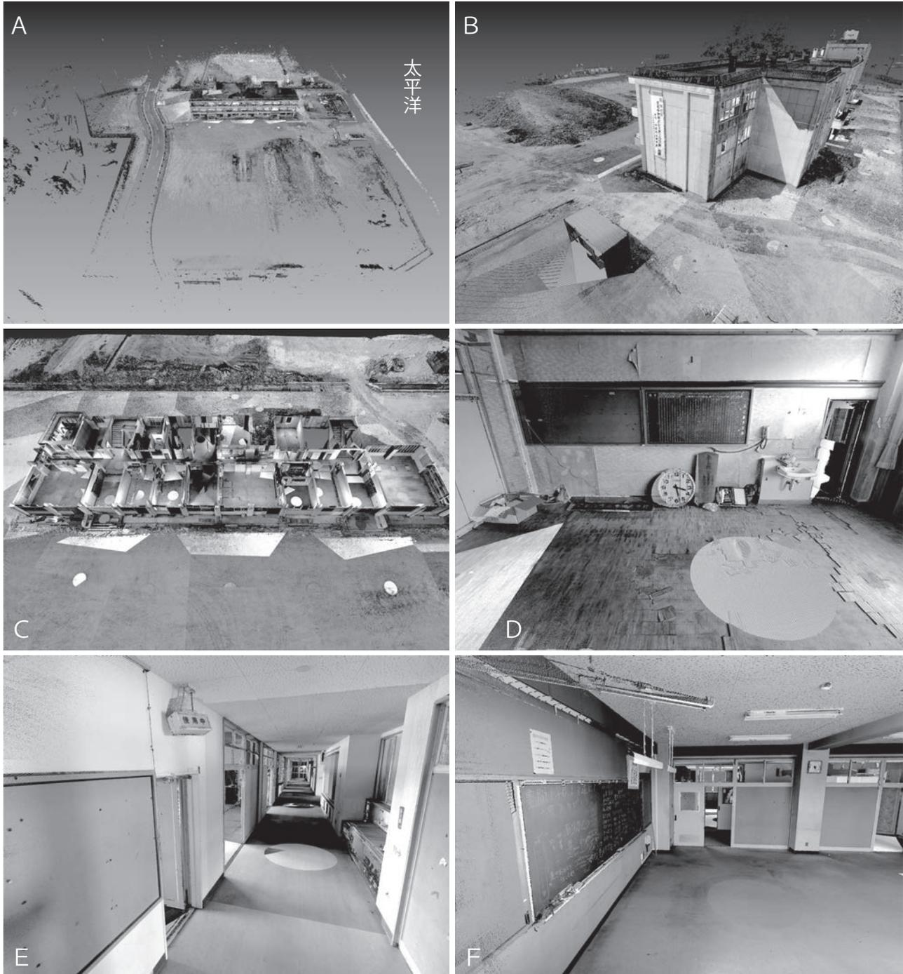
図 63. いわき市立豊間中学校旧校舎。A：計測範囲。B：校舎北東側から。C：校舎1階。D：1階の部屋に集められた時計や看板などの保存物品。E：1階放送室前。表示灯が曲がっている。F：3階美術室。黒板に卒業生などのメッセージが書かれている。
