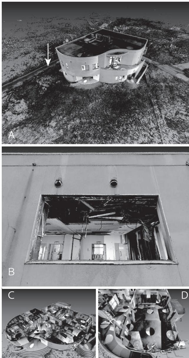
図 38. 浪江町南棚塩集会所。A: 全景。矢印は本文中に記載した津波の浸水深の基準となる道路面。B: 建物外から見た 2 階ホールの天井の様子。C: 1 階の様子。D: 2 階ホールの様子。
