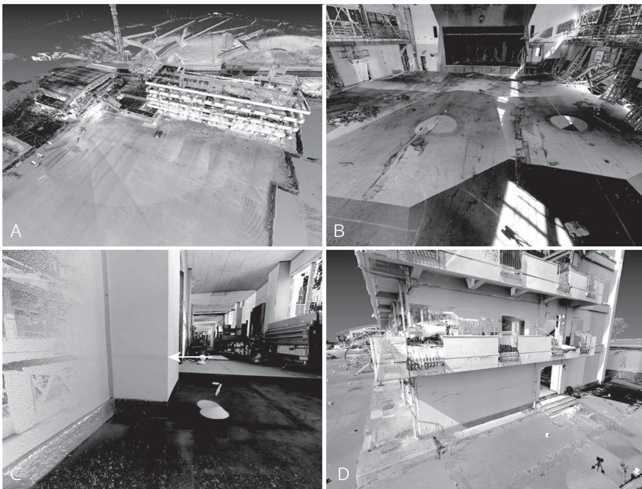
図 24. 仙台市立旧荒浜小学校。A：旧荒浜小学校遠景。B：体育館内部を南側から見た様子。C：校舎 2 階廊下に残された津波の浸水跡（矢印）。D：校舎東側の破壊された 2 階の手すり。
