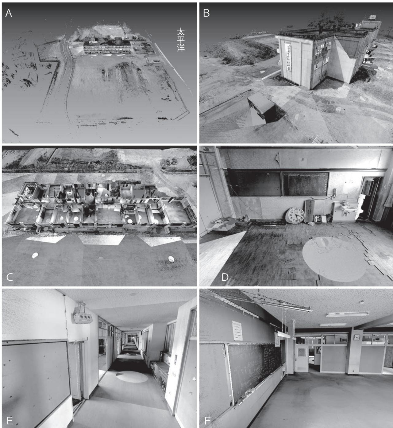
図 63. いわき市立豊間中学校旧校舎。A：計測範囲。B：校舎北東側から。C：校舎1階。D：1階の部屋に集められた時計や看板などの保存物品。E：1階放送室前。表示灯が曲がっている。F：3階美術室。黒板に卒業生などのメッセージが書かれている。
