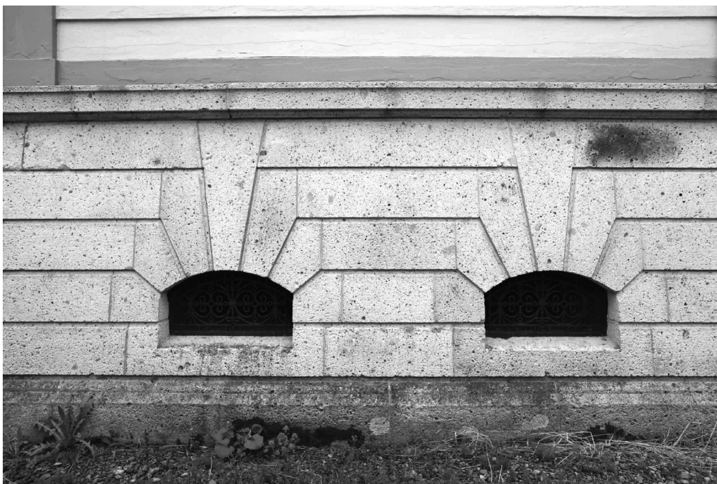
図1. 米沢高等工業学校本館 (上) 本館全景 (下) ルスティカ部分
