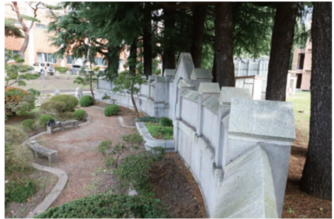
図 12 地上撮影による壁面裏側からの写真の例
