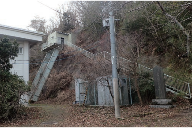
計測時の保存施設・電気は復旧していない
