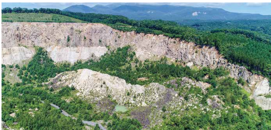
荒砥沢ダム上流の大規模地滑りによる崩壊地
